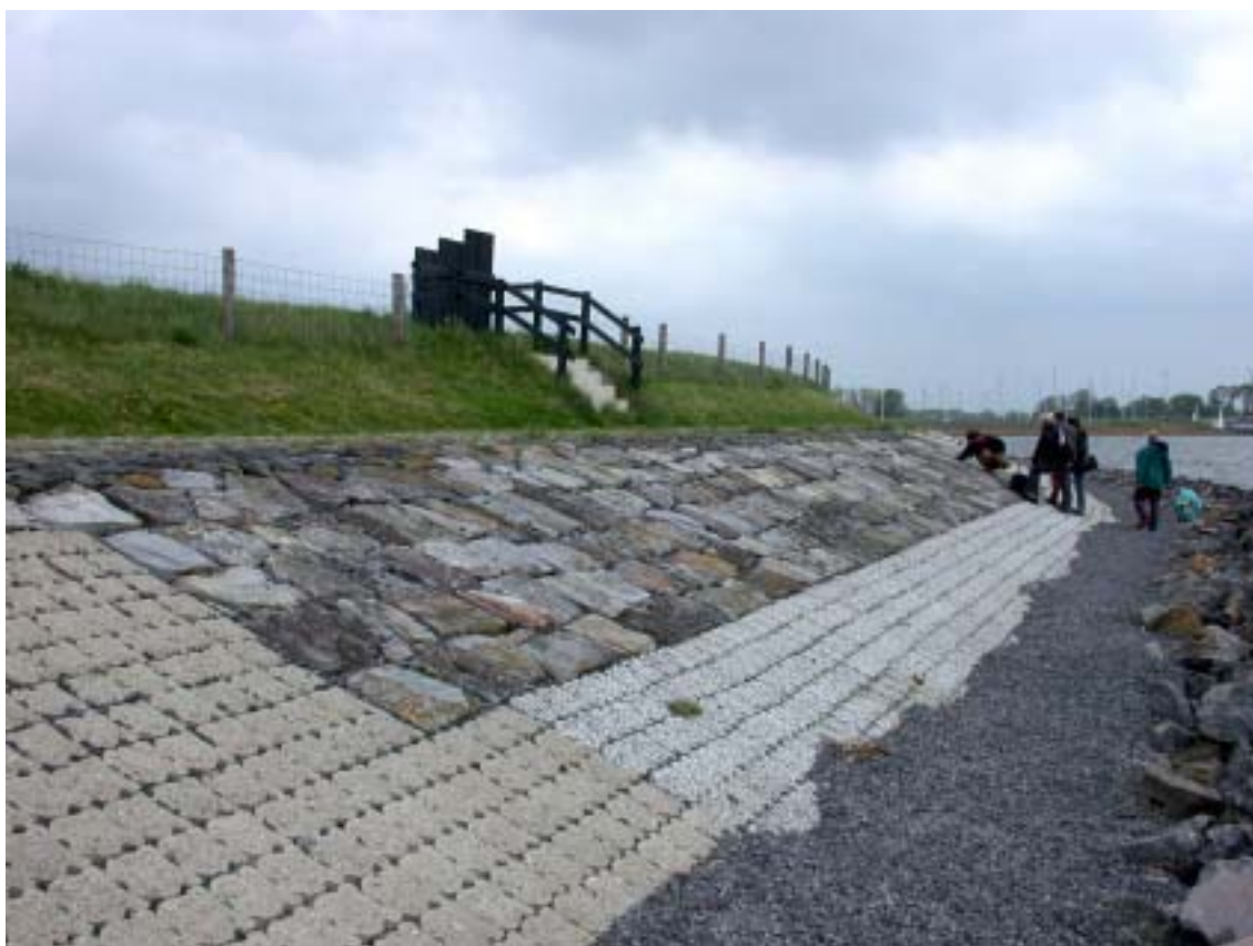
Foto 2. Proefvlak Amstelmeer 2. Grote blokken kalksteen van de oude dijkbekleding zijn hergebruikt. Eromheen liggen betonzuilen, rechts met en links zonder 'ecokoppen'.
